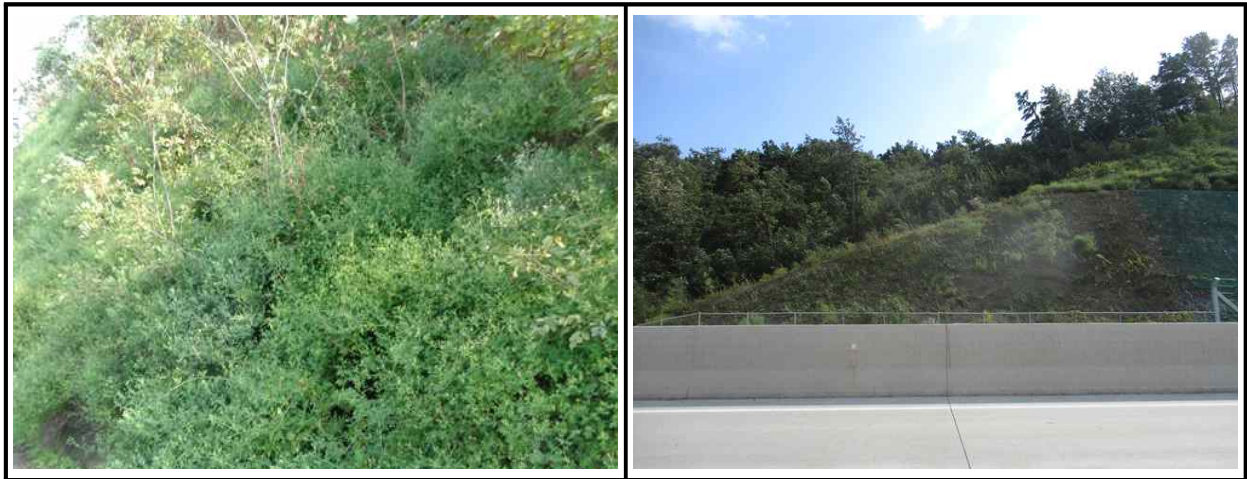
【그림 45.3.1】 상부자연사면 전경
