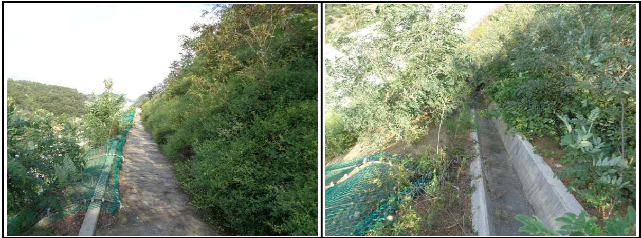
【그림 45.3.3】 배수시설 전경
